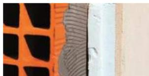
**Aislamiento térmico eficaz** El poliestireno extruido confiere excelentes propiedades de aislamiento térmico para un espesor reducido del panel, permitiendo así corregir los puentes térmicos y garantizando la continuidad del aislamiento. Tienen una importante contribución al ahorro de energía y al cumplimiento de los requisitos RITE.
