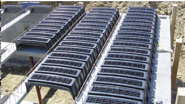
Elementos utilizados para a construção de lajes aligeiradas. Alternativa válida às tradicionais abobadilhas cerâmicas ou de betão, pois garante um peso da laje muito inferior.
